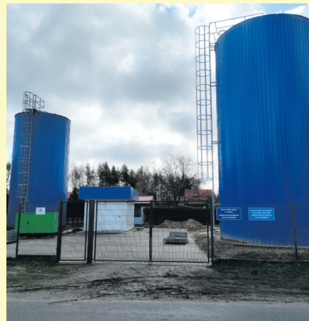
Nowy zbiornik w Janowie zabezpieczy dostawę wody bez przerw na jego uzupełnienie, szczególnie w czasie upałów
