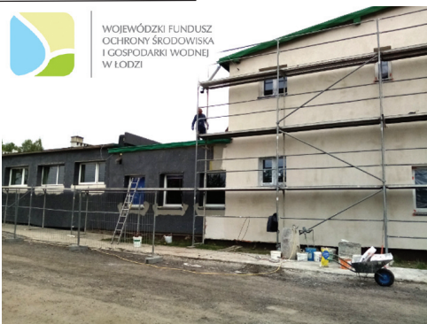
foto: trwa termomodernizacja budynku szkoły w Dąbrówce Wielkiej
