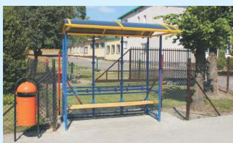
Do połowy sierpnia zamontowano 14 nowych wiat przystankowych na terenie gminy. Niebawem pojawi się 6 kolejnych.
