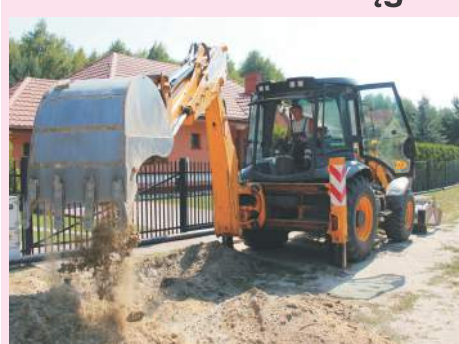
Trwa rozbudowa sieci wodociągowej, realizowana przez GZK. Oddano do użytku kilka odcinków wodociągu, m.in. w Lućmierzu i Glinniku. Cały czas trwają prace nad wykonaniem kolejnych wyczekiwanych przez mieszkańców fragmentów wodociągowej infrastruktury. Na fot.: budowa wodociągu przy jednej z ulic w Rosanowie.
