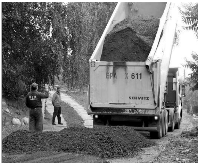
Utwardzenie drogi destruktem, prace na odcinku Skotniki - Łagiewniki
