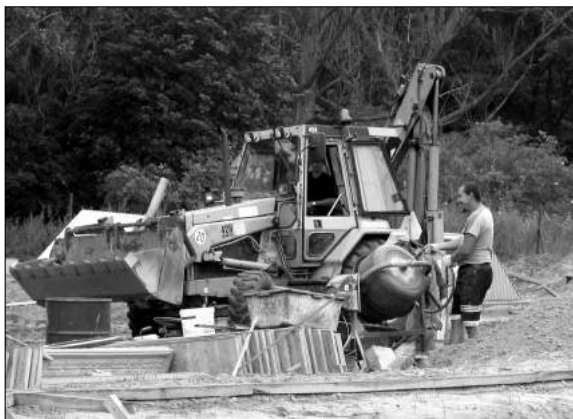
Budowa oczyszczalni w Lu mierzu
