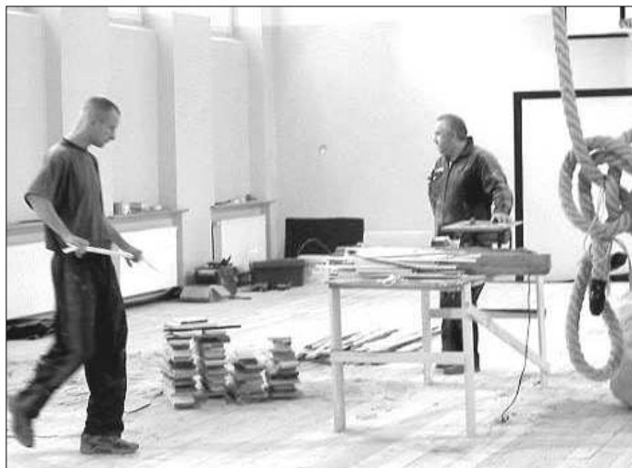
Prace przy układaniu podłogi w sali gimnastycznej
