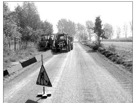
Nowa, utwardzona nawierzchnia na drodze Dobrej wka - Rosanów
