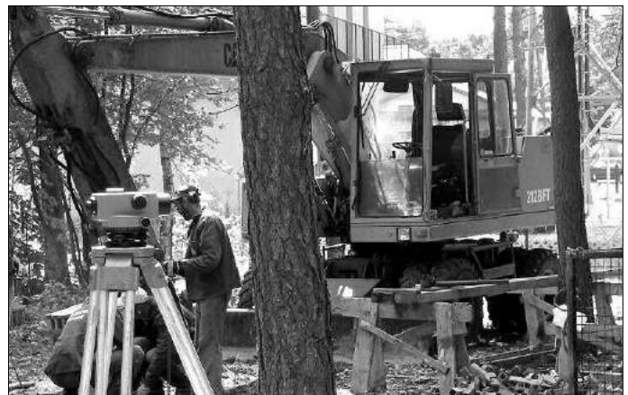
Trwają prace związane z rozbudową stacji wodociągowej w Ustroniu
