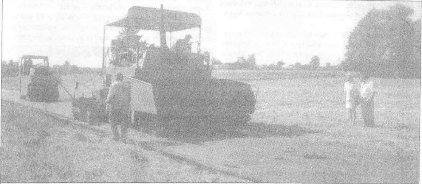
Budowa nakładki asfaltowej na drodze w Ciosnach. Fot. Tomasz Soldenhoff
