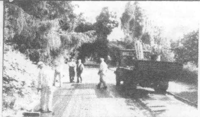
Prace na ul. Lipowej w Grotnikach.
