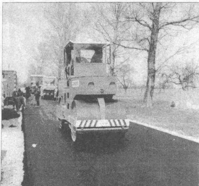
Budowa nawierzchni bitumicznej drogi gminnej Kotowice - Astachowice - Wypychów. Fot. Tomasz Soldenhoff
