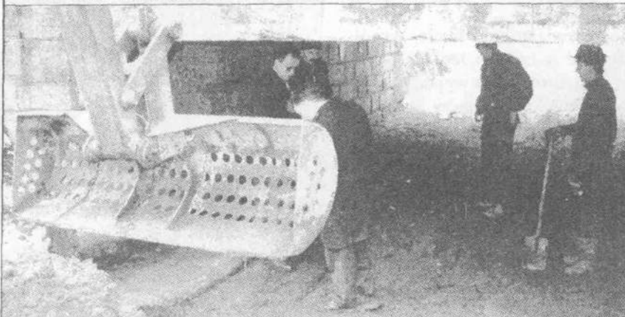
16 marca prace wykonywane w przejściu pod wiaduktem na ul. Kolejowej w Grotnikach sprawdzili Zastępca wójta gminy Zgierz, Zdzisław Rembisz i Dariusz Kłys.
