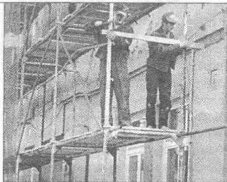
Modernizacja elewacji budynku UGZ.
