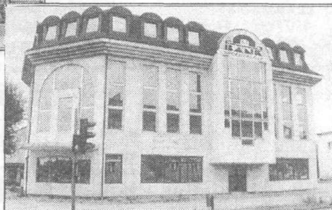
Nowa siedziba Banku Spółdzielczego przy ul. Długiej 62A
