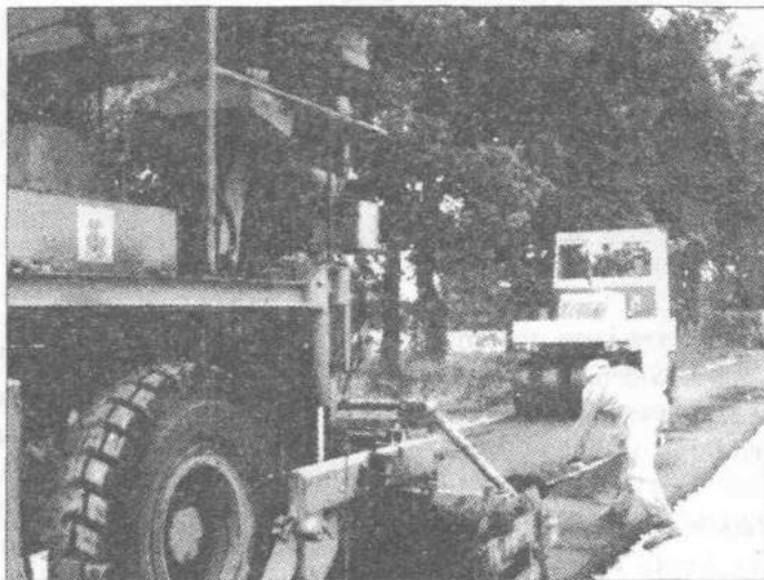
Praca na przebudowie drogi Gieczno - Borowiec.
