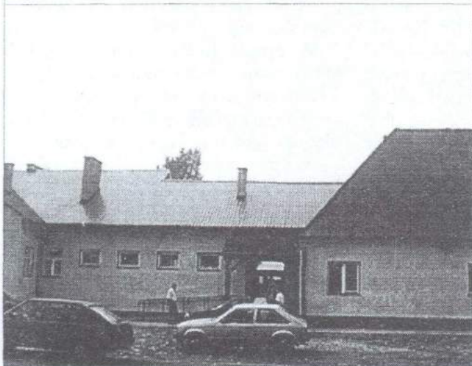
Rozbudowana Szkoła Podstawowa w Białej
