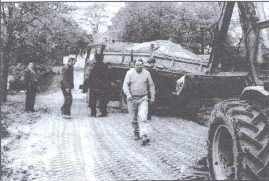
Naprawa przepustu w Kotowicach
