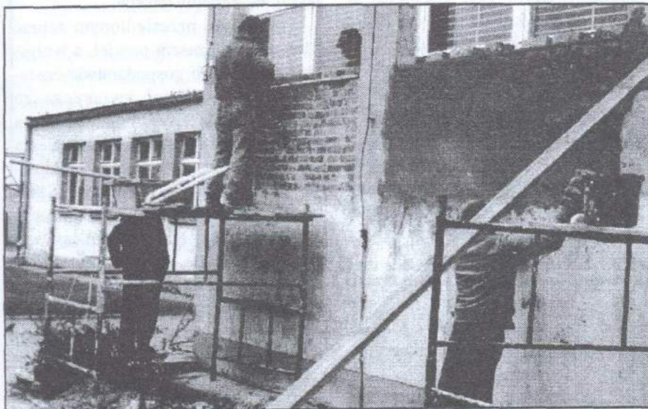
Prace remontowe w szkole podstawowej w Słowiku
