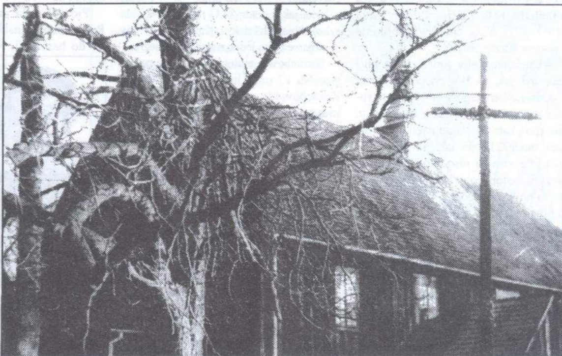
Kościół w Giecznie zdaje się być naturalnym wykwitem gruntu, na którym stoi...
