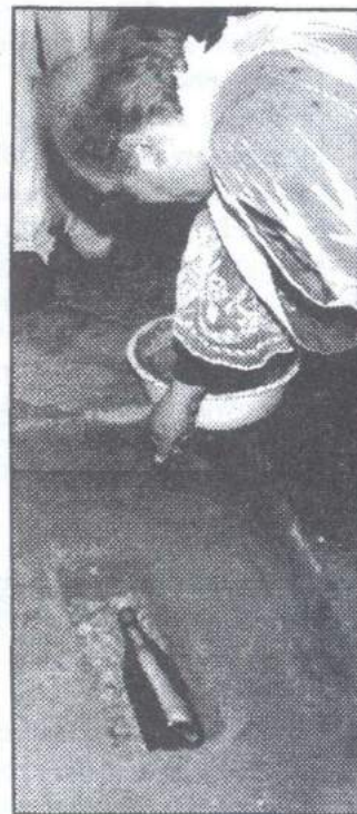
Wmurowanie aktu erekcyjnego
