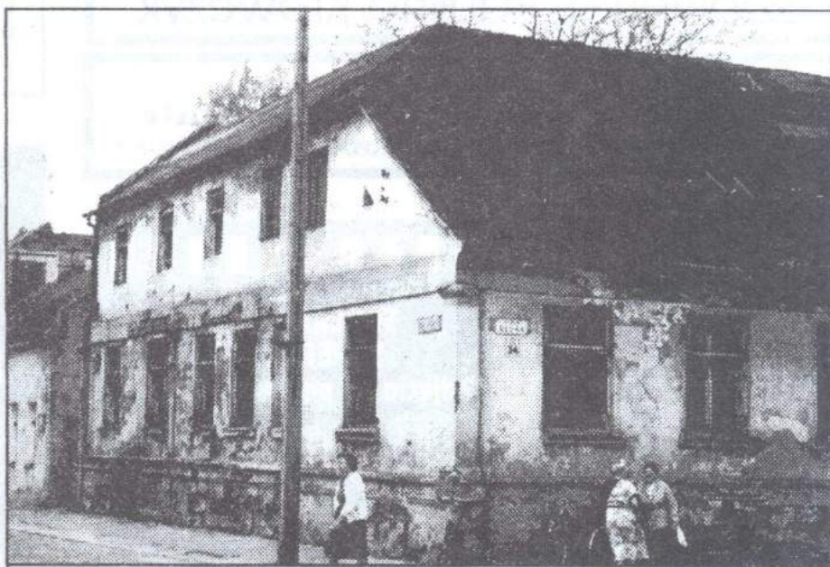
Bank Spółdzielczy w budowie Fotografia nadesłana na konkurs Banku Spółdzielczego
